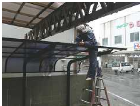
屋根材を一枚ずつ取り外します
