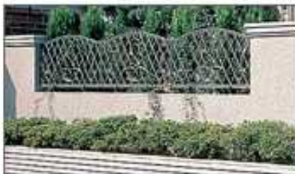
ブロックフェンス施工
